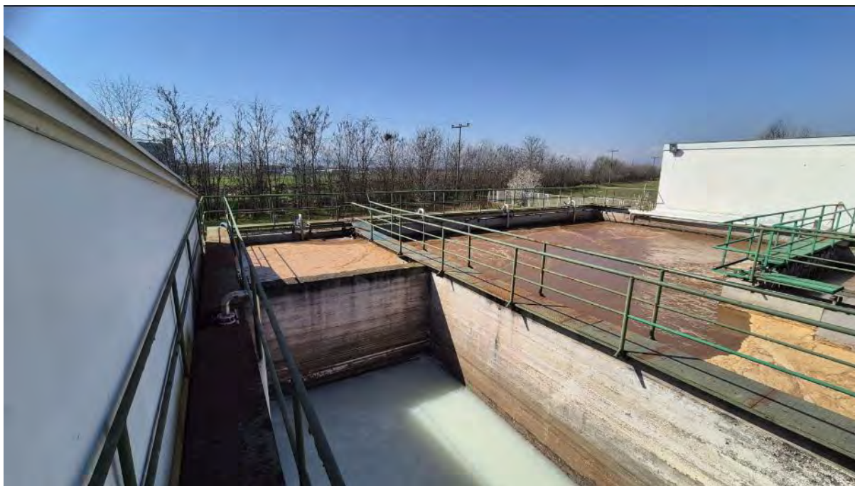
Слика бр: 37 Прочистителна станица
