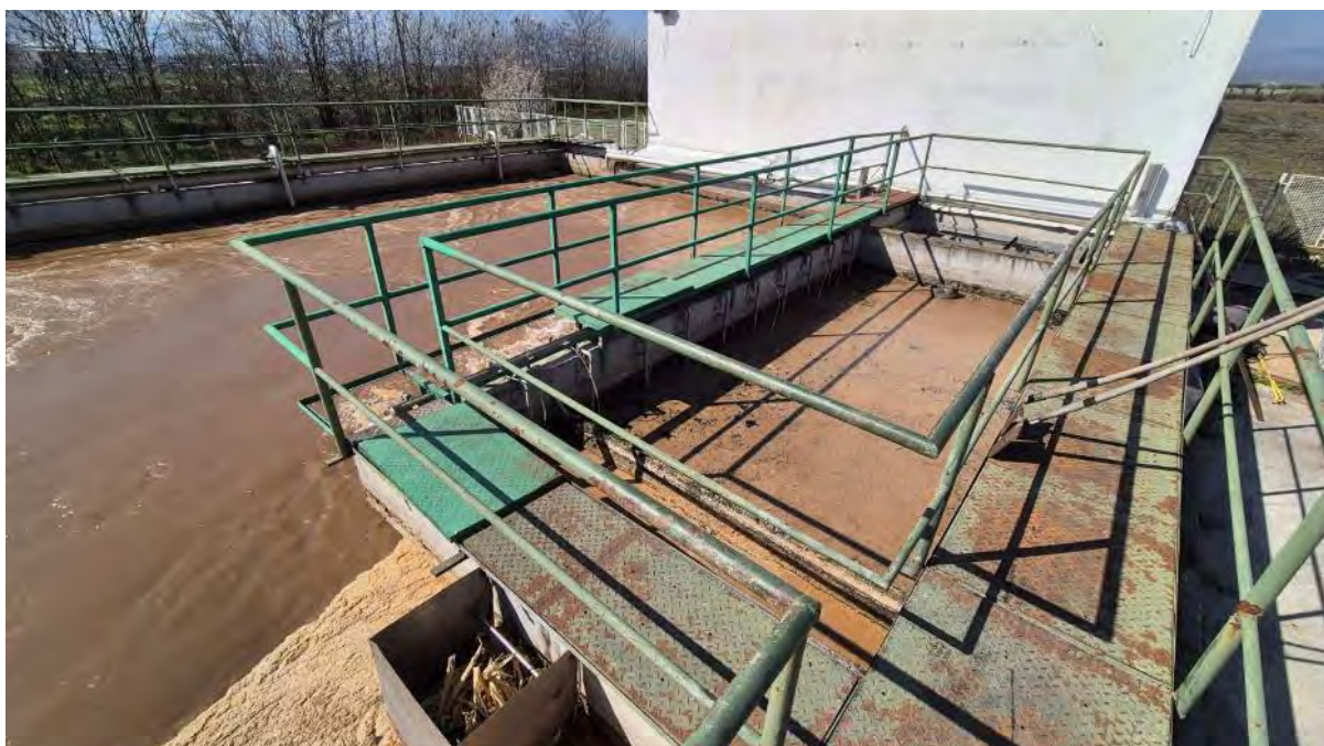
Слика бр: 36 Прочистителна станица
