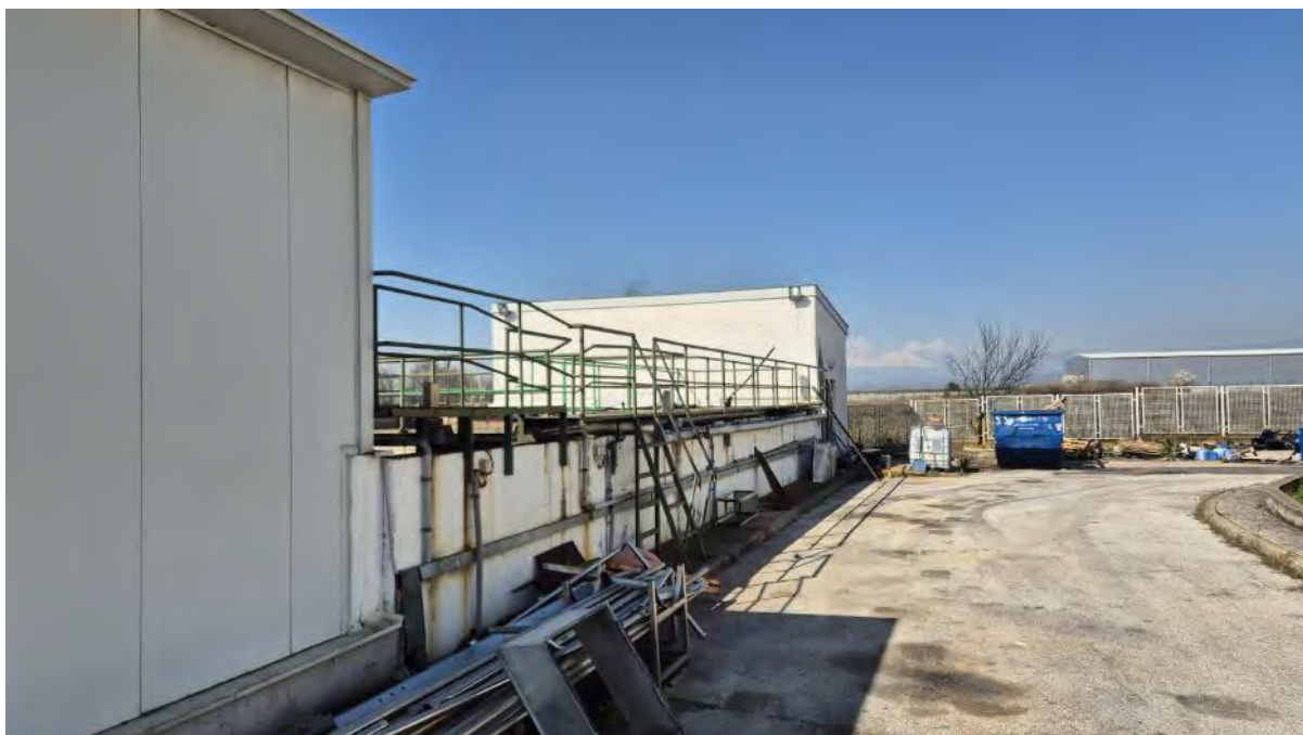
Слика бр:35 Прочистителна станица
