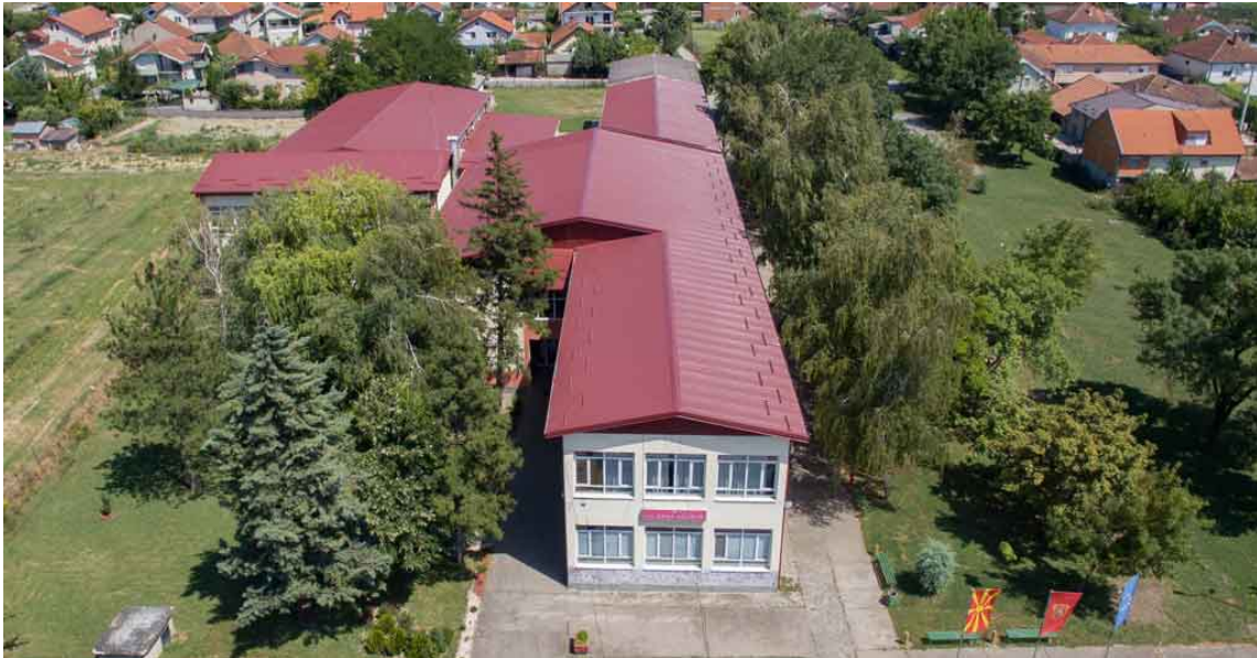
Фотографија од извршена замена на кровната конструкција на општинското основно училиште „Гоце Делчев“
