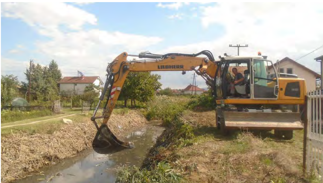
Фотографија од чистење на отворени одводни канали
